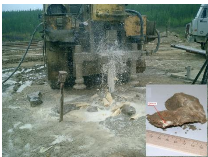
Разбуривание зоны скважины с криогелем
